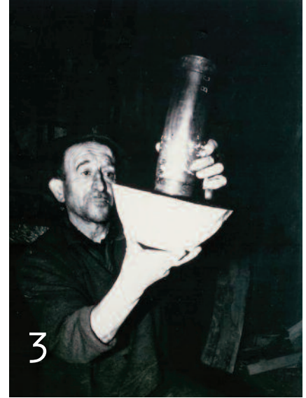
Delphin Berger dit P'tio Clain : l'un des derniers tourneurs à perche de la Magne. Il vérifie le bon centrage de la r'bate (le mandrin).
